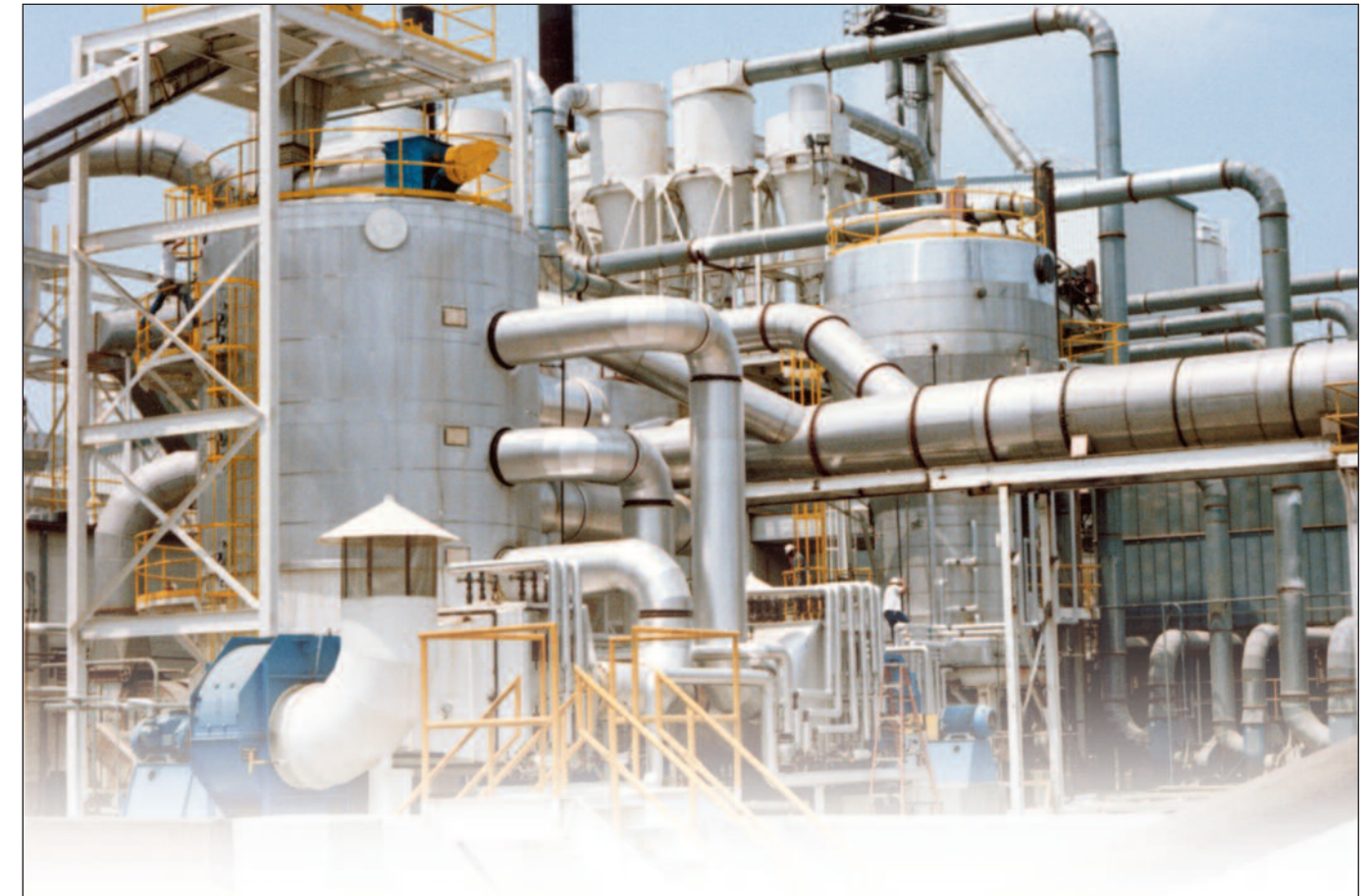
El DC ha demostrado ser muy eficiente y eficaz tecnología para secar y enfriar todas las harinas provenientes de extracción continua de semillas oleaginosas. El DC incluye las ventajas de 1 DTDC cuando se utiliza con un DT.
